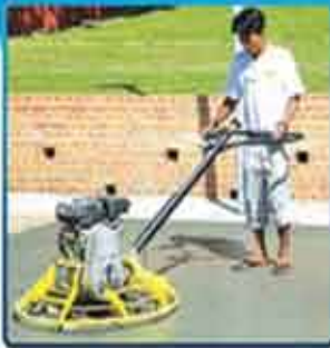
Floor Hardener တွန့်ကရစ်ကြမ်းခင်းမာစေသော နည်းလမ်း
